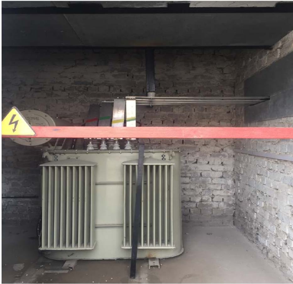
Замена оборудования РП, ТП(АРЭС)
